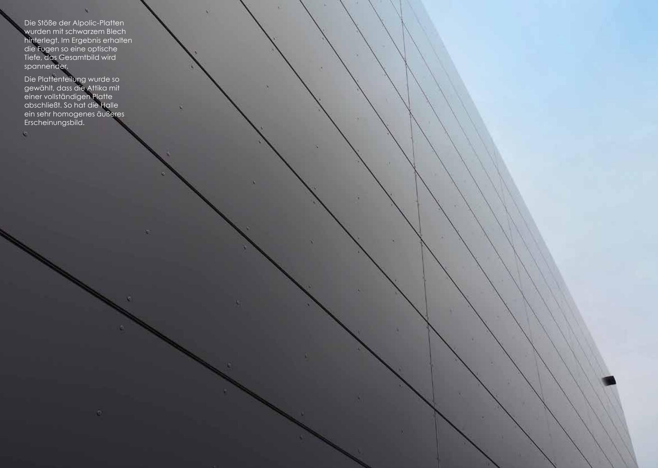
Die Stöße der Alpolic-Platten wurden mit schwarzem Blech hinterlegt. Im Ergebnis erhalten die Fugen so eine optische Tiefe, das Gesamtbild wird spannender.
