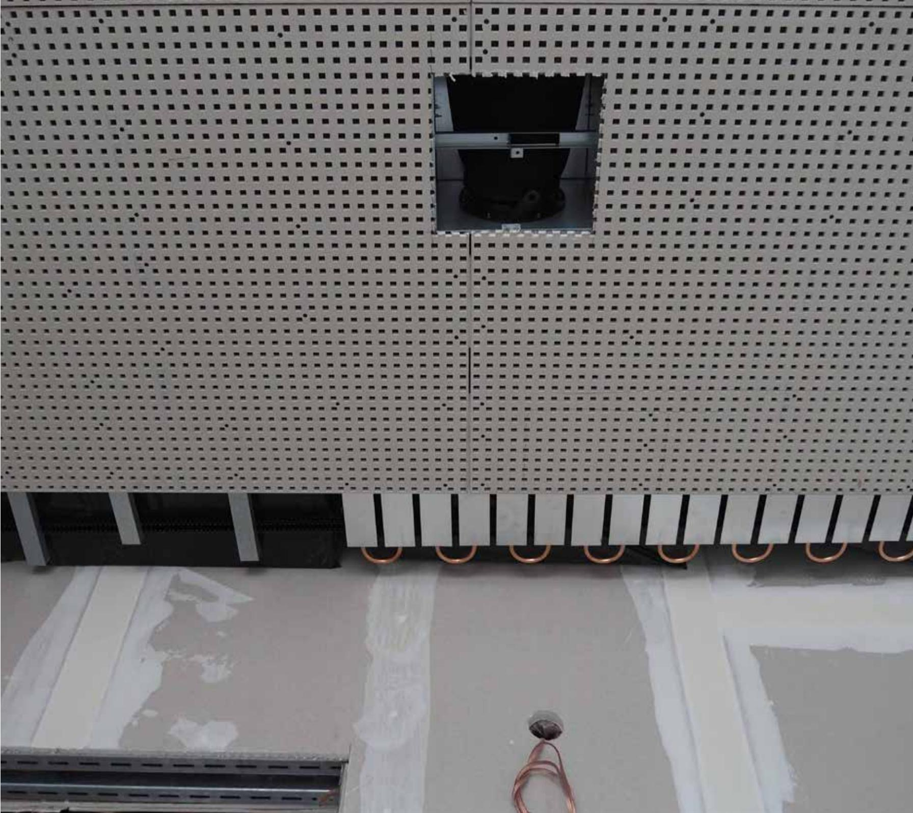
Die Deckenelemente der Kantwerg-Decke werden mit gelochten Gipskartonplatten Verkleidet.
