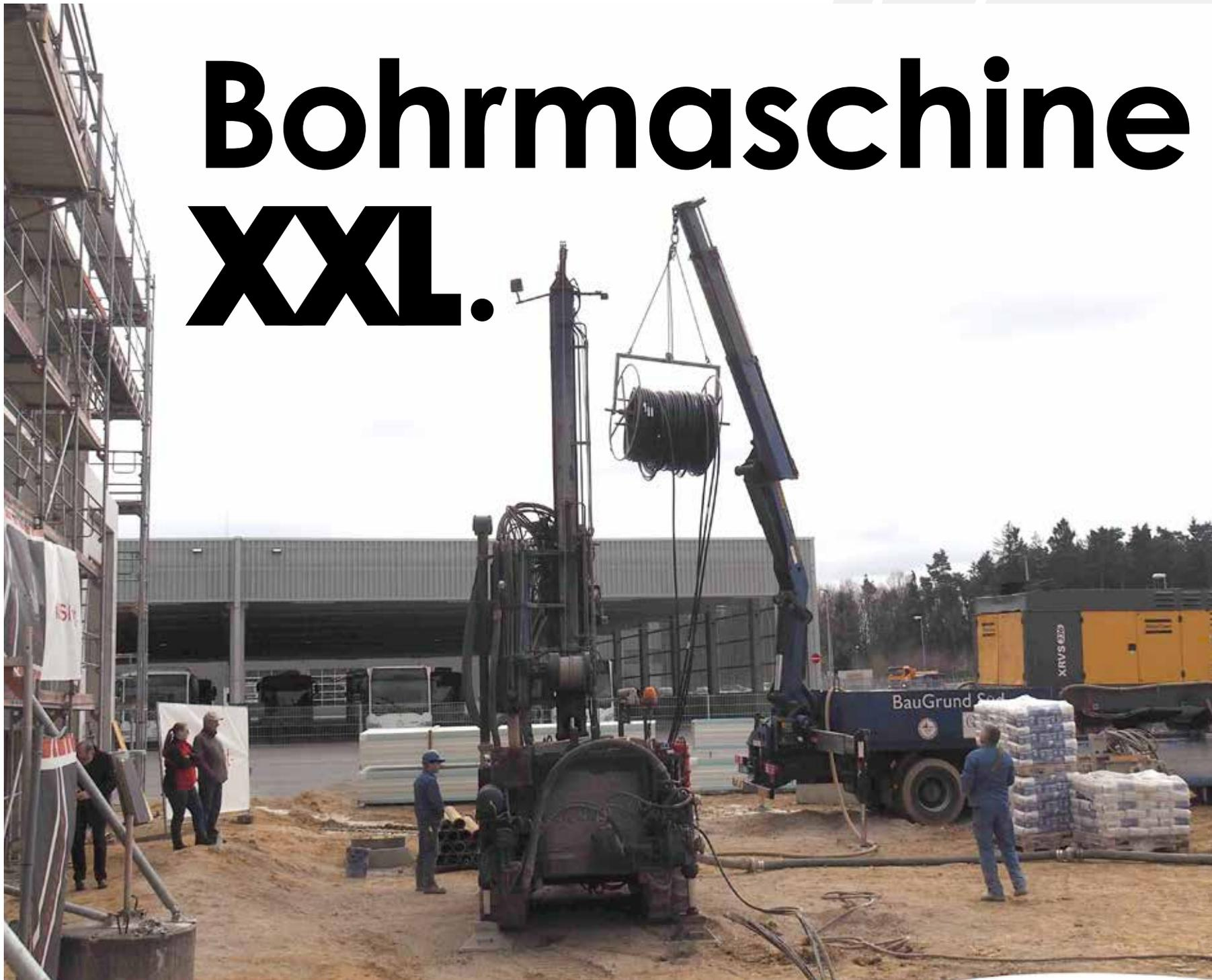
Konzernkompetenzen: Die Bohrspezialisten erledigten die neun Erdbohrungen mit knapp 100 Metern Tiefe für die Sole/Wasser Wärmepumpe, die für die Gebäudeklimatisierung sorgt.
