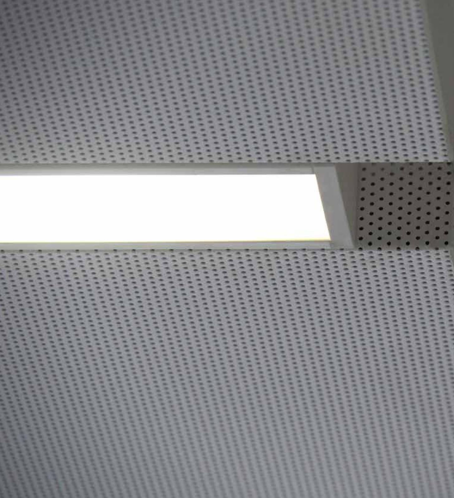
Das Deckenelement im Foyer stellt eine weitere technische Besonderheit dar: Sowohl die Beheizung als auch Kühlung des Gebäudes wird durch das Deckenpaneel ermöglicht. Die gelochte Struktur wiederum wirkt sich positiv auf die Raumakustik aus. Zusätzlich wurde ein Beleuchtungselement in LED-Technik eingebaut.
