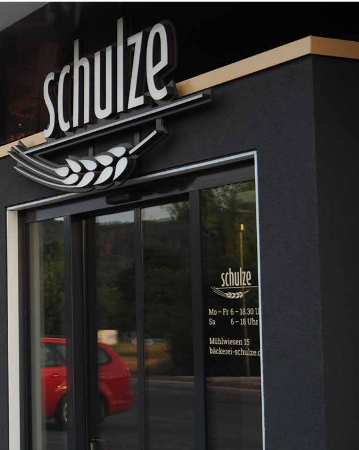
Das Vordach mit einer Stahlunterkonstruktion und Verkleidung aus gefrästem und gekantetem Alucobond ist eine Eigenentwicklung unserer Ingenieure und Stahlbaumeister. Die Ausführung erledigen wir selbst mit unserem eigenen Personal.
